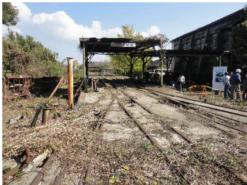
写真6 第2斜坑の巻き上げ機室とトロッキの線路
