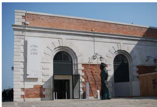
写真2. プンタ・デッラ・ドガーナ入り口付近外観
