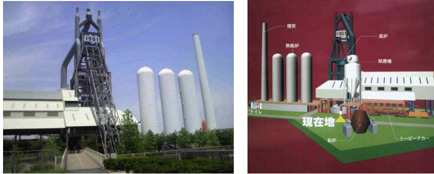
図4. 東田第一高炉とその概略図 (写真は東田第一高炉跡広場にて筆者が撮影)
